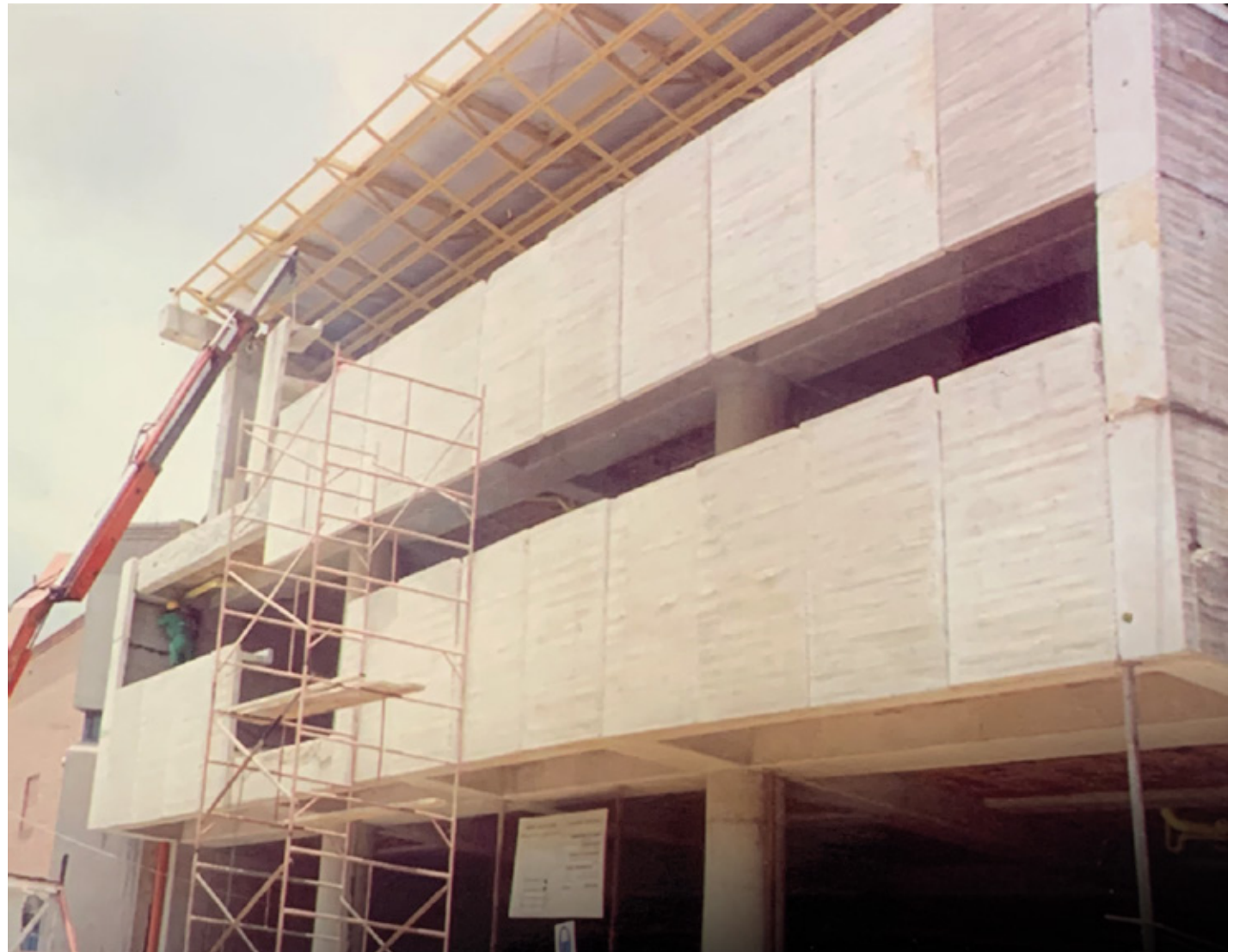
2002, Inauguración Planta Toberín
